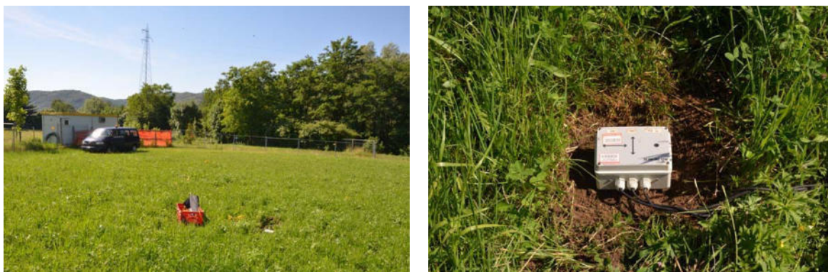
Figura 1 – Foto sensori - Ubicazione (sinistra) e dettaglio (destra).
