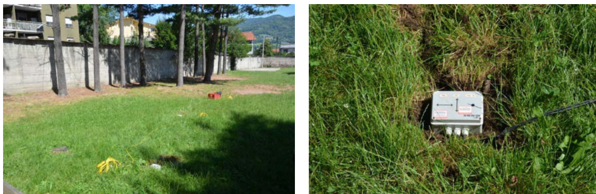
Figura 1 – Foto sensori - Ubicazione (sinistra) e dettaglio (destra).
